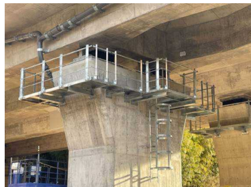
弊社製作検査路:施工後一例 【茨城県 吉原高架橋】
